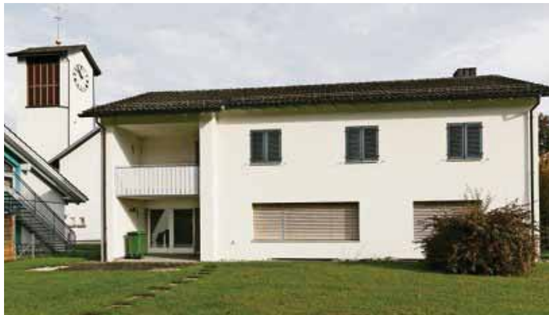
Nah bei Schule, Kindergarten und Bahnhof: Das Pfarrhaus Kollbrunn bietet der Kita einen zentralen Standort. jb
